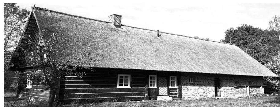
Straßenansicht des Wohnstallhauses in Blockhaus- und Backsteinbauweise
