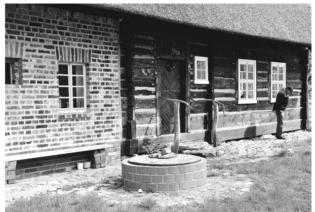
Ansicht von der Hofseite
