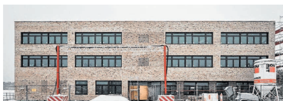
Erweiterung des Primärbereichs, Schulstraße 1, Döbern Foto: Architektenkammer Brandenburg
