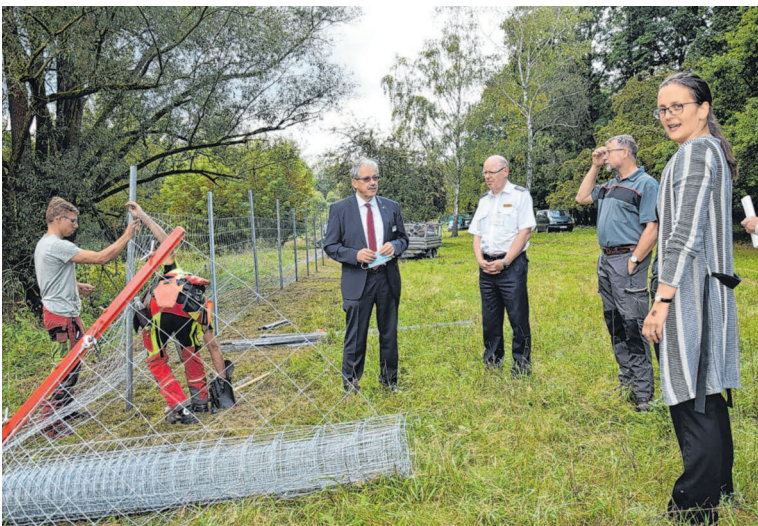
Landrat Harald Altekrüger vor Ort beim Zaunbau gegen die ASP
