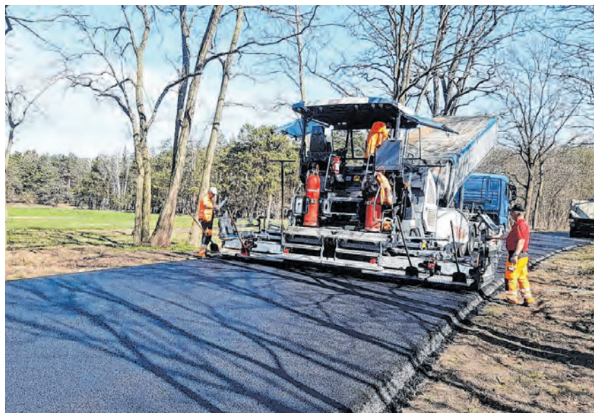
Im Frühling geht es wieder los. Die Planung für Modernisierungs- und Erneuerungsarbeiten an den Kreisstraßen ist für 2022 weitgehend abgeschlossen. F.: Pressestelle SPN
