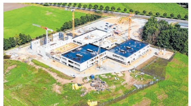
Blick über die Baustelle der Gesamtschule Spree-Neiße Foto: Landkreis Spree-Neiße/Wokrejs Sprjewja-Nysa
