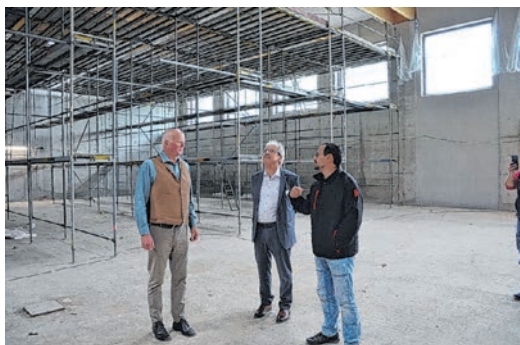
Landrat Harald Altekrüger (M.) und Baudezernent Olaf Lalk (I.) informierten sich vor Ort über den aktuellen Baufortschritt der Gesamtschule Spree-Neiße.
