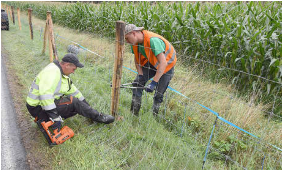
Arbeiten an ASP-Schutzzäunen
